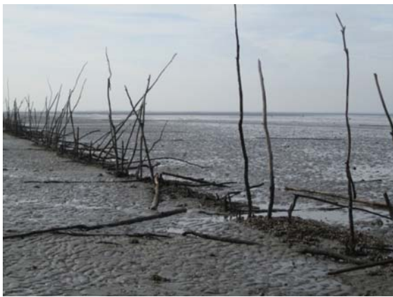
De ijsgang heeft veel houten staken geknakt of zelfs afgebroken.
